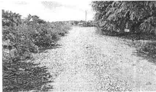
กม. ๐.๕+๕๐๐ (สภาพสายทางโดยทั่วไป)
