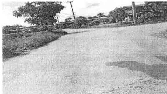
กม. ๐.๐+๑๐๐ (สภาพสายทางโดยทั่วไป)
