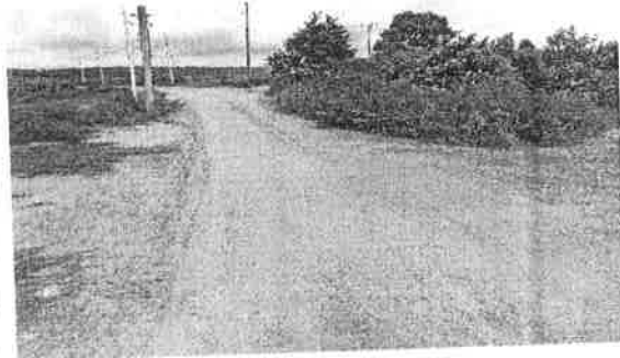
กม. ๐.๑+๕๐๐ (สภาพสายทางโดยทั่วไป)
