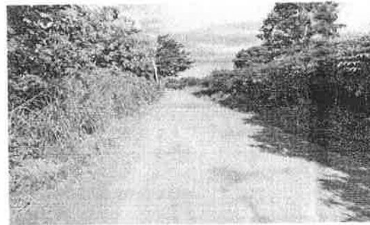
กม. ๐.๕±.๕๐๐ (สภาพสายทางโดยทั่วไป)
