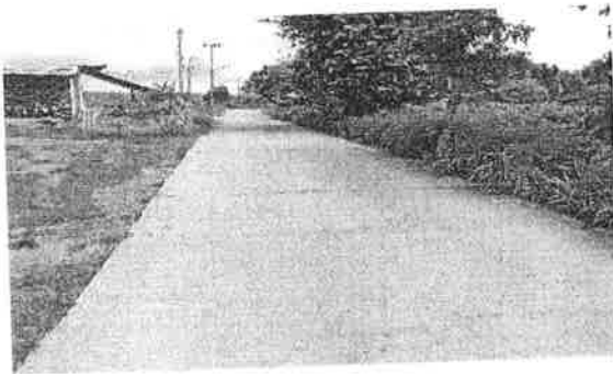
กม. ๐.๑+๐๐๐ (สภาพสายทางโดยทั่วไป)
