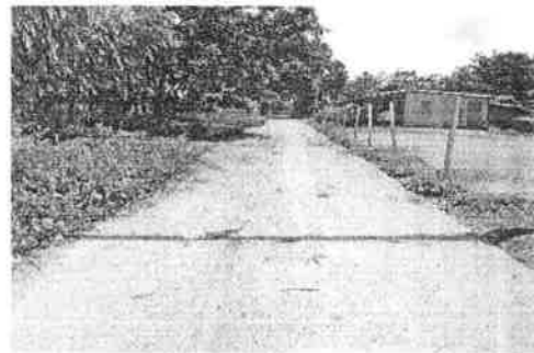
กม. ๐.๐±๕๐๐ (สภาพสายทางโดยทั่วไป)
