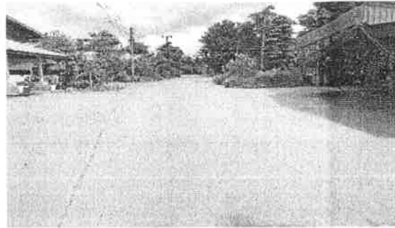
กม. ๐.๐+๕๐๐ (สภาพสายทางโดยทั่วไป)
